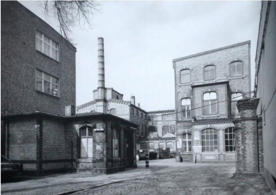
dienten, in der Mitte das Kesselhaus mit Schornstein. Die Außenfassade ist sorgfältig mit gelbem Backstein gemauert und mit rotem Backstein abgesetzt. Die abwechslungsreiche Gestaltung der Sprossenfenster orientierte sich an der Nutzung der dahinterliegenden Räume. Als selten schönes Beispiel der Berliner Industriearchitektur steht das Ensemble unter Denkmalschutz.
