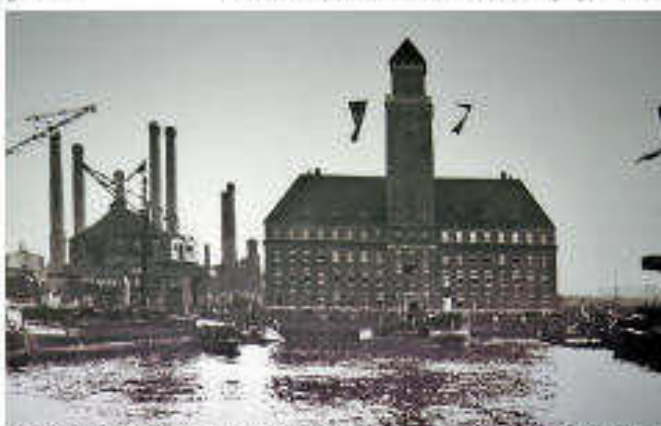
Der markante, 52 Meter hohe auf dem Hauptgebäude diente als Wasserturm und hier insbesondere für die Versorgung der Dampfmaschinen der Kaffelbahn.
